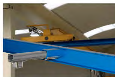
SOPORTES SOLDABLES A VIGA
