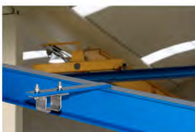
PLETINAS SOLDADAS A LA VIGA
